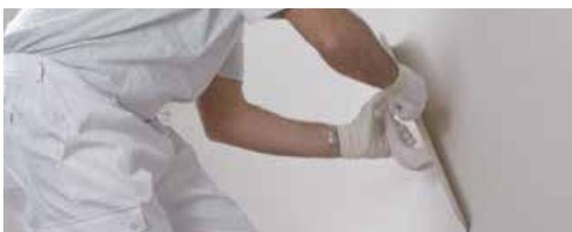
**3** Cortar con una cuchilla de acero para eliminar las pequeñas imperfecciones.
