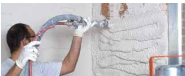
**1** Proyectar sobre el soporte ajustando el caudal de agua para obtener una masa consistente y trabajable.
