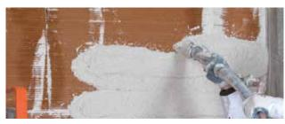
Proyectar sobre el soporte ajustando el caudal de agua para obtener una masa consistente y trabajable.
