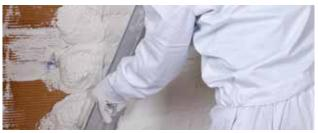
3 Cortar con una cuchilla de acero para eliminar las pequeñas imperfecciones.
