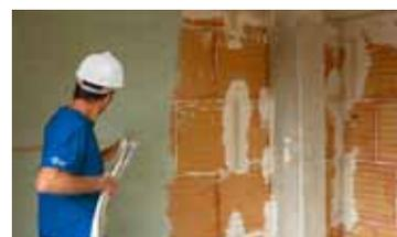
**4** Mezclar el producto mediante máquina de proyección de caudal hasta conseguir una consistencia adecuada.
