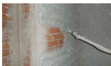
**1** Mezclar el producto mediante máquina de proyección de caudal hasta conseguir una consistencia adecuada.
