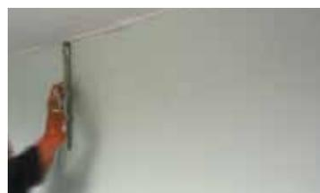
**5** Proyectar la superficie y reglear hasta conseguir una superficie lo suficientemente plana. Cortar con una cuchilla de acero para eliminar las posibles imperfecciones.
