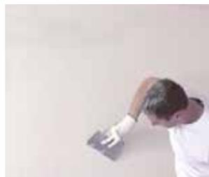
**4** El revestimiento no se puede recubrir antes de 2 horas y hasta el secado total (variará según el espesor aplicado y la temperatura y humedad existentes).
