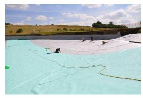
En general, las soldaduras entre láminas se realizan con aire caliente o con cuños calientes, mediante un soplete manual o automático. También pueden realizarse a soldadura única o a doble soldadura con un canal central, que permite hacer una comprobación con aire comprimido.
