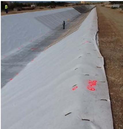
El geotextil GEOLAND HT se coloca suelto, sin tensarlo, libre de pliegues y arrugas; se procura colocarlo en contacto directo con el suelo evitando cualquier espacio vacío entre el terreno y el geotextil.
